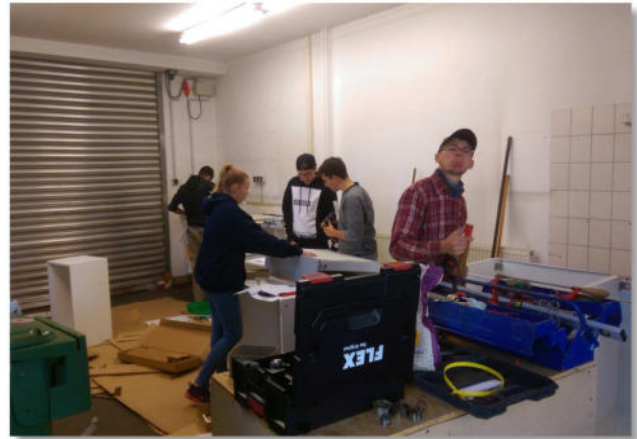
Fleißige Hände beim Renovieren der Fahrzeughalle
